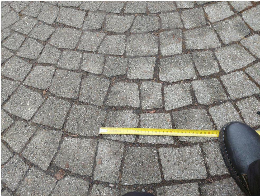
Příklad stávajícího chodníku z betonových kostek 60 mm do vlaštovky, nové chodníky u SO 01 – FARNÍ ZAHRADY, SPODNÍ ČÁST budou provedeny stejným způsobem.
